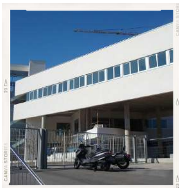
2010. Fin obra nuevo centro
